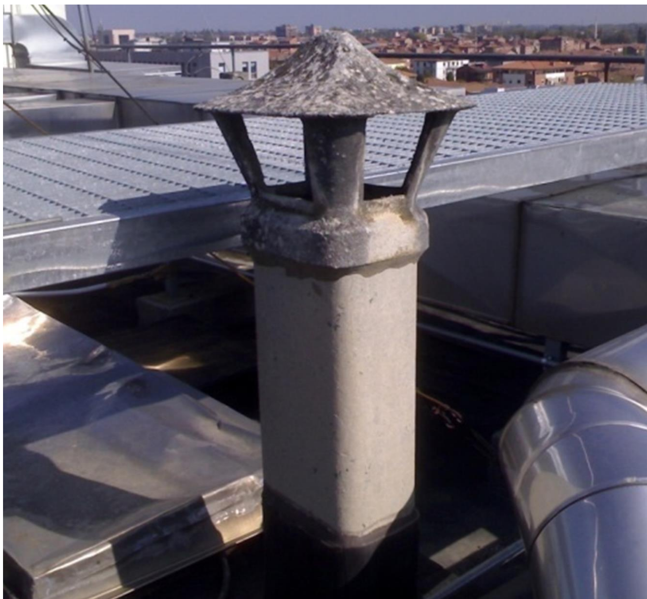
Fig. 13.5 – Un camino costruito in cemento-amianto ancora presente sul tetto di un edificio nella città di Modena (foto originale di A.F. Gualtieri).
